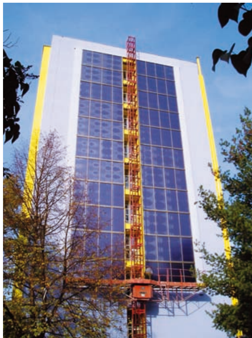
Jižní stěna po umístění posledního panelu.
