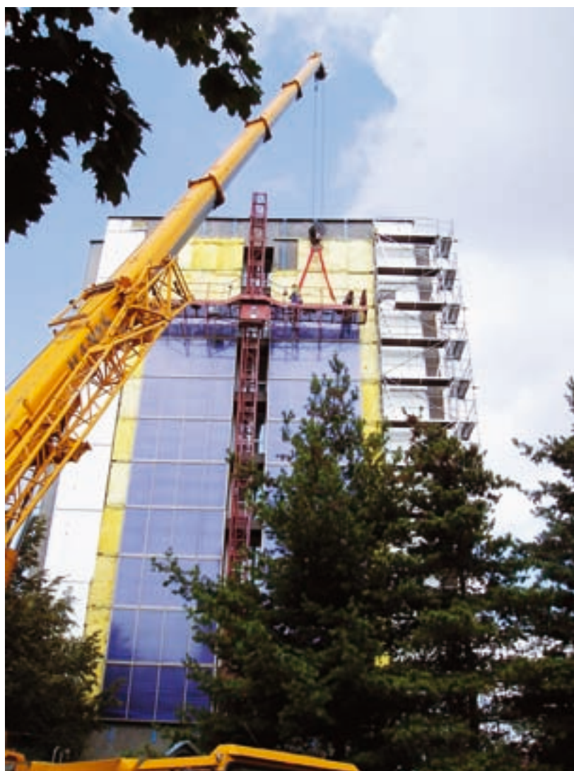
Jednotlivé panely vynášel nahoru autojeřáb.
