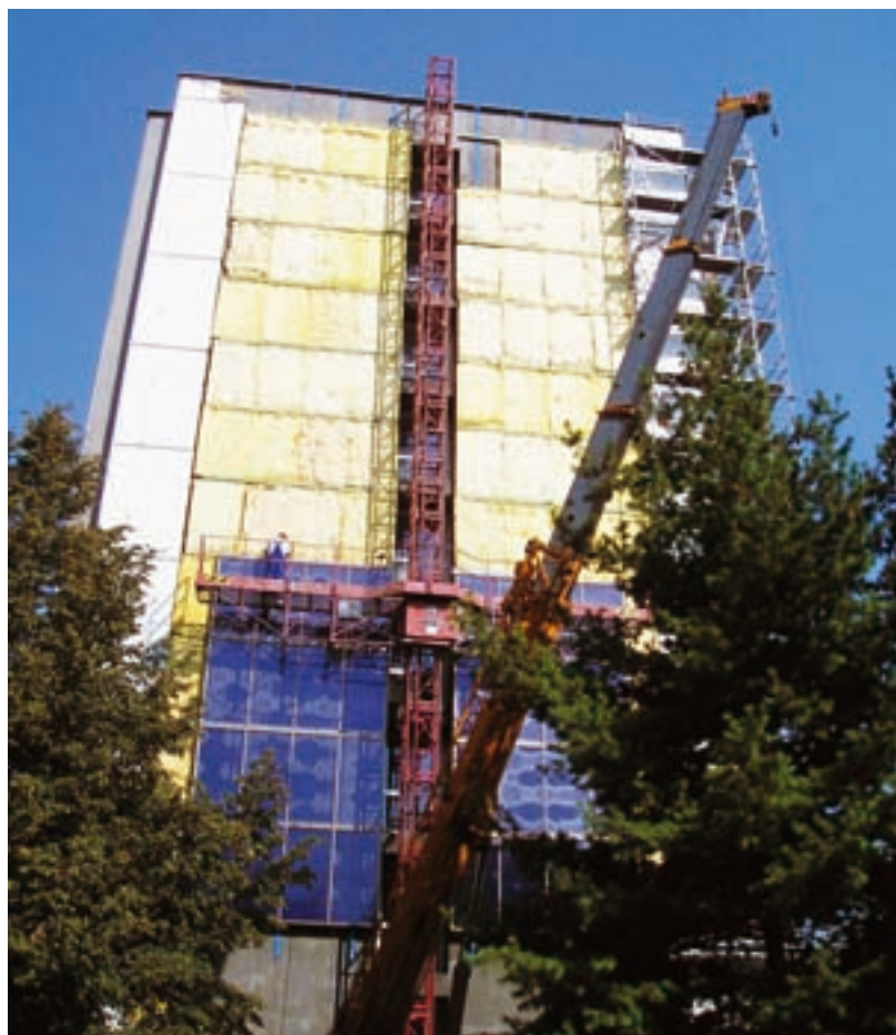
Kolektory byly instalovány odspodu na vrstvu kamenné vlny.
